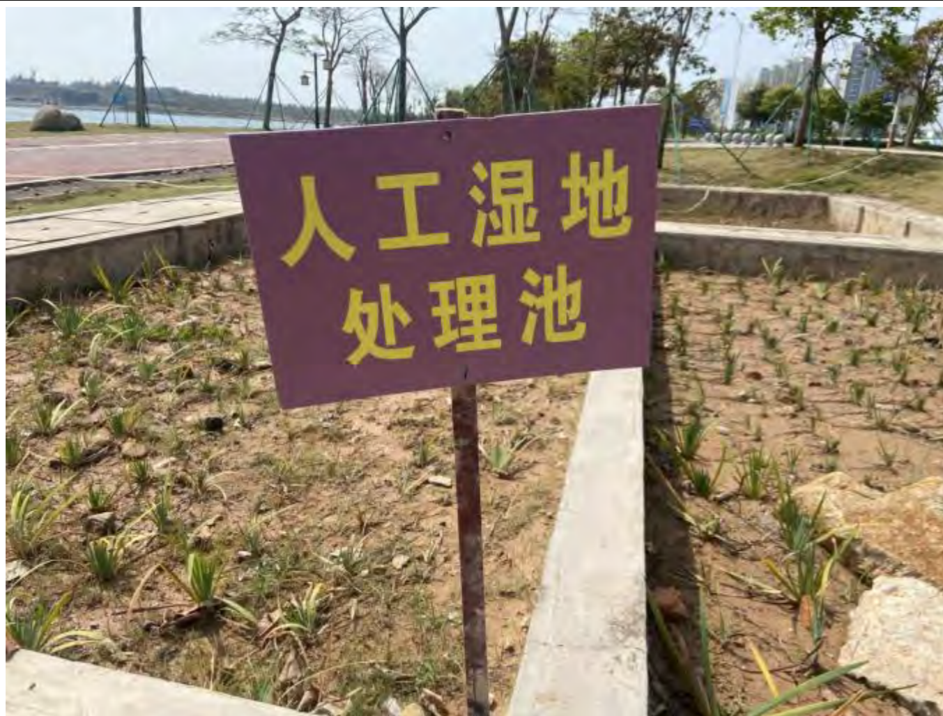
人工湿地污水处理设施 1
